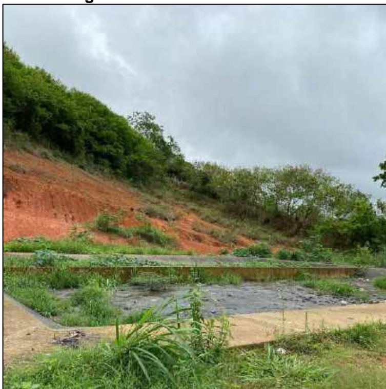
Figura 53 – Leito de secagem do lodo localizado no Aterro Sanitário de Muriaé.
