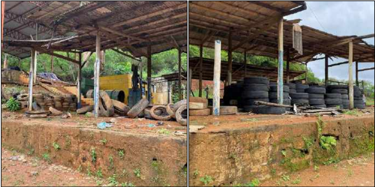
Figura 77 – Galpão de armazenamento de pneus inservíveis.
