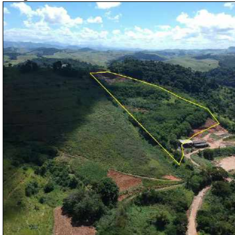
Figura 13 – Vista aérea do Aterro Controlado.
