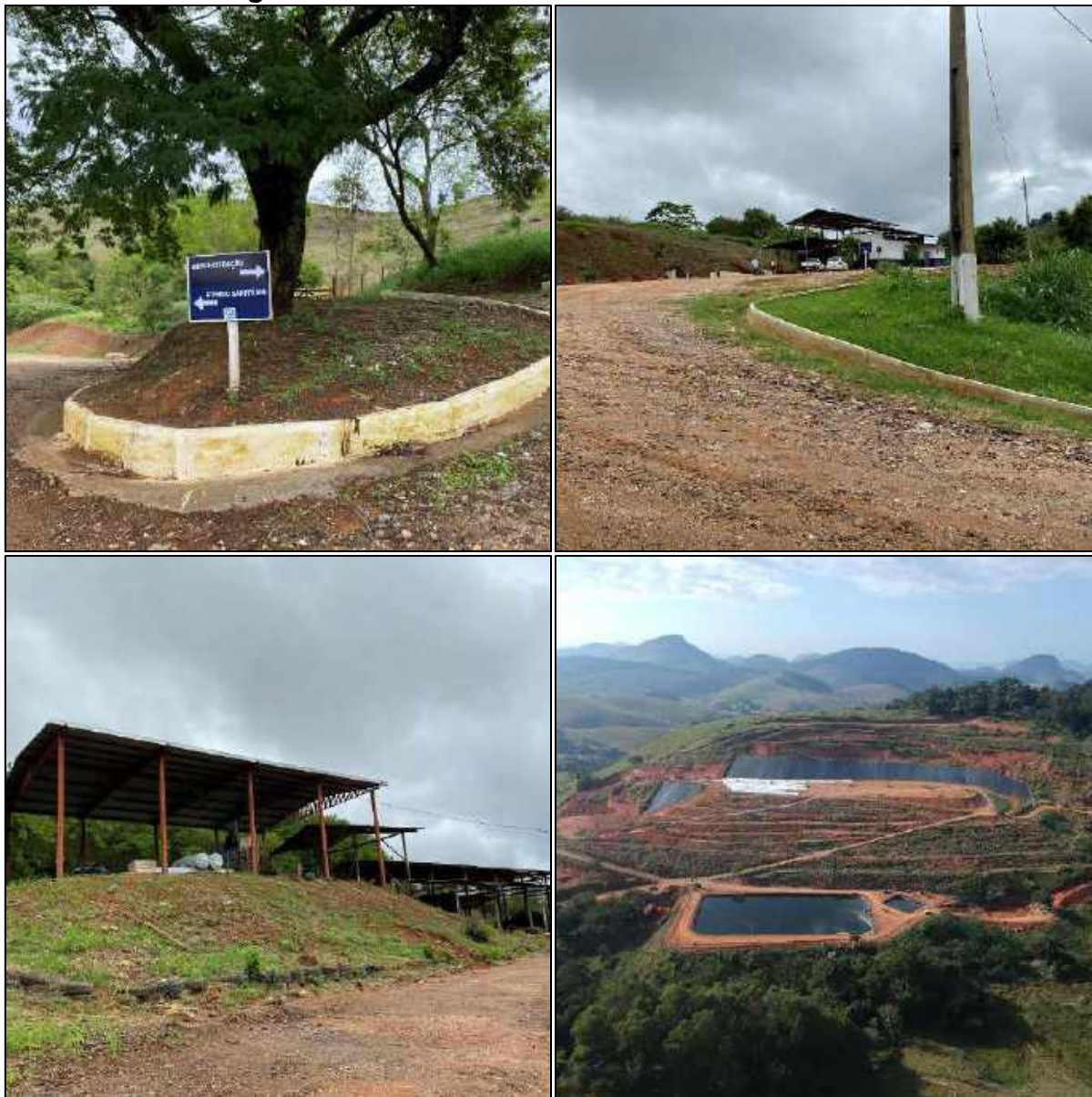
Figura 11 – Fotos do Aterro Sanitário de Muriaé.
