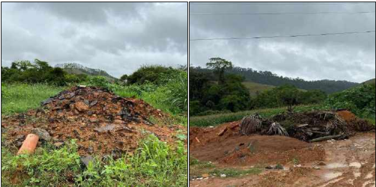
Figura 59 – Área licenciada para disposição final de resíduos da construção civil.
