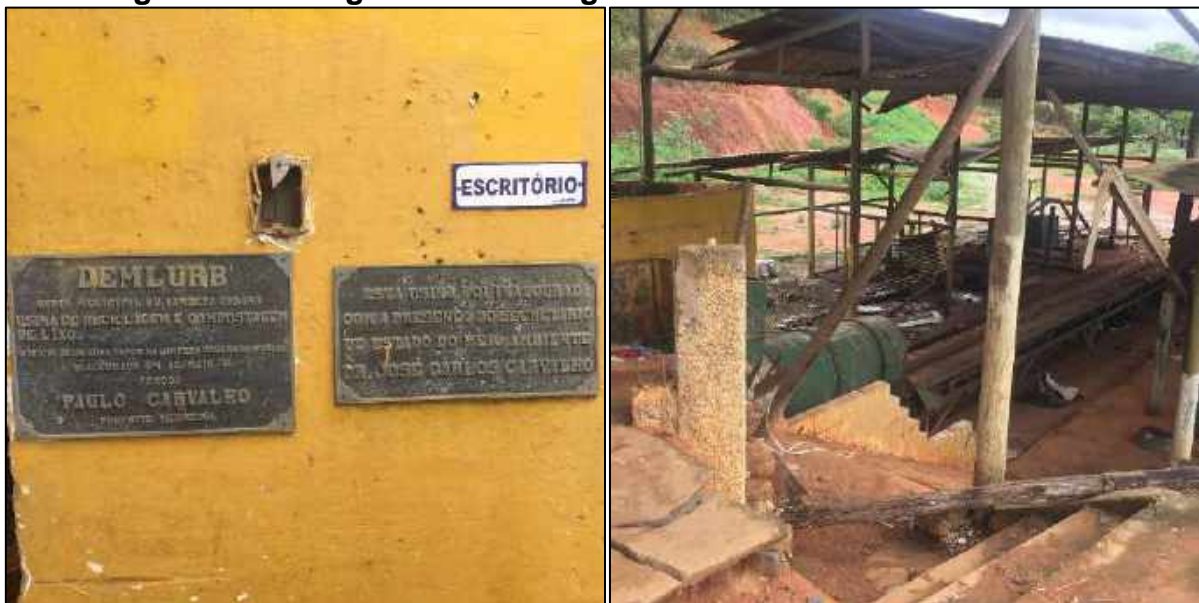
Figura 16 – Antiga usina de triagem do Aterro Sanitário de Muriaé.
