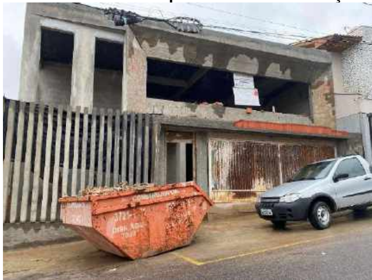
Figura 55 – Acondicionamento temporário de RCC em caçambas metálicas.
