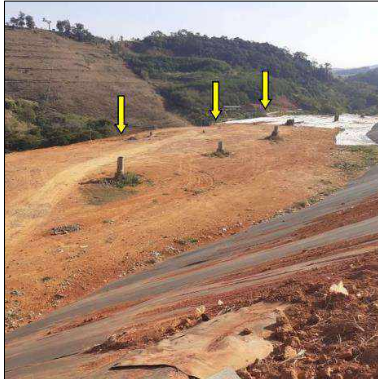
Figura 20 – Sistema de drenagem de gases do Aterro Sanitário de Muriaé.
