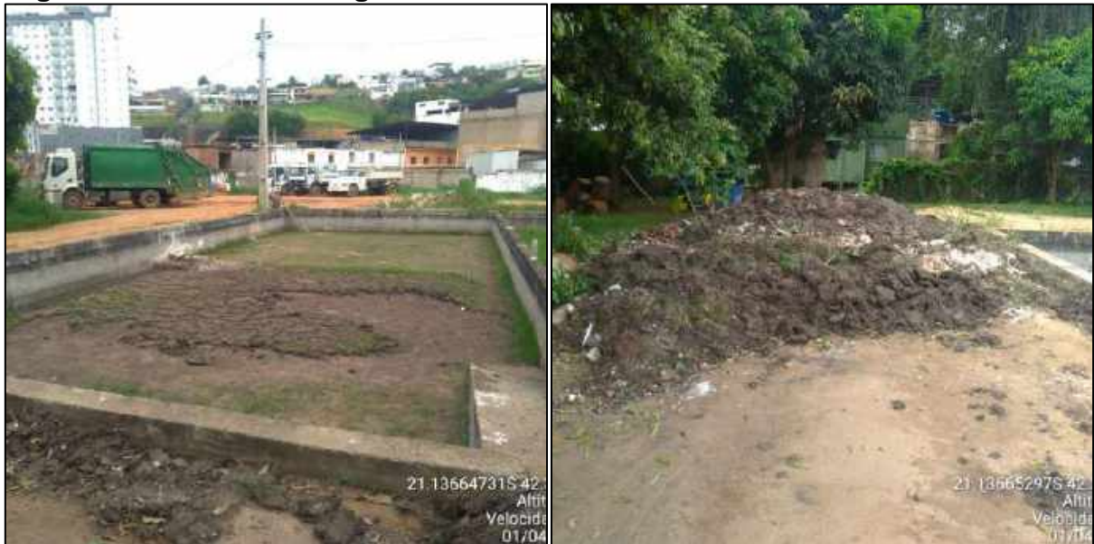
Figura 51 – Leito de secagem e acondicionamento do lodo seco na ETE Safira.
