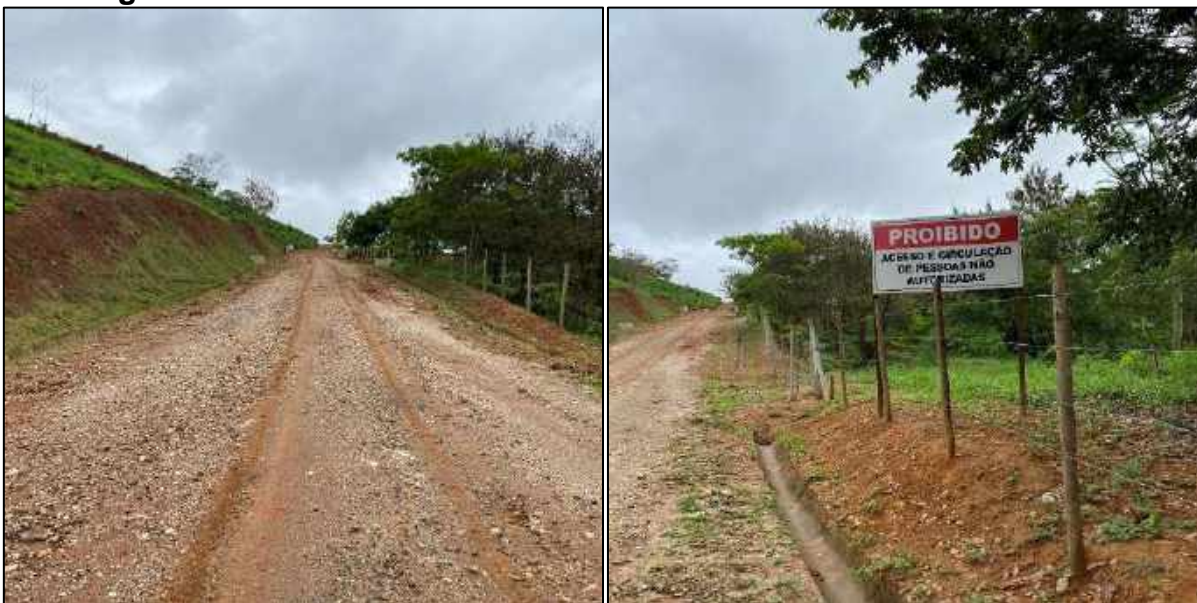
Figura 14 – Área cercada e sinalizada no Aterro Sanitário de Muriaé.
