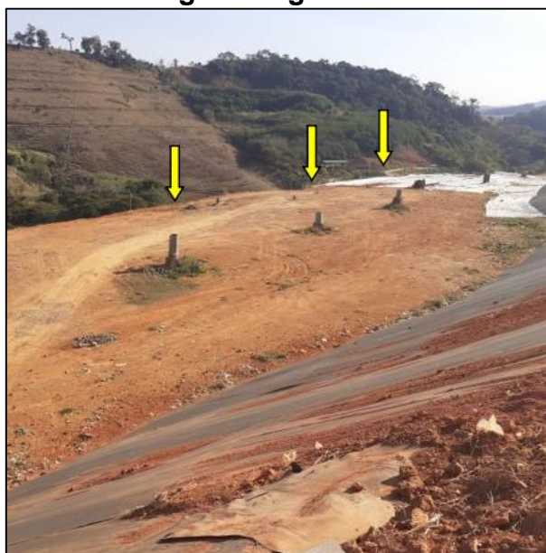
Figura 24 – Sistema de drenagem de gases do aterro sanitário de Muriaé.
