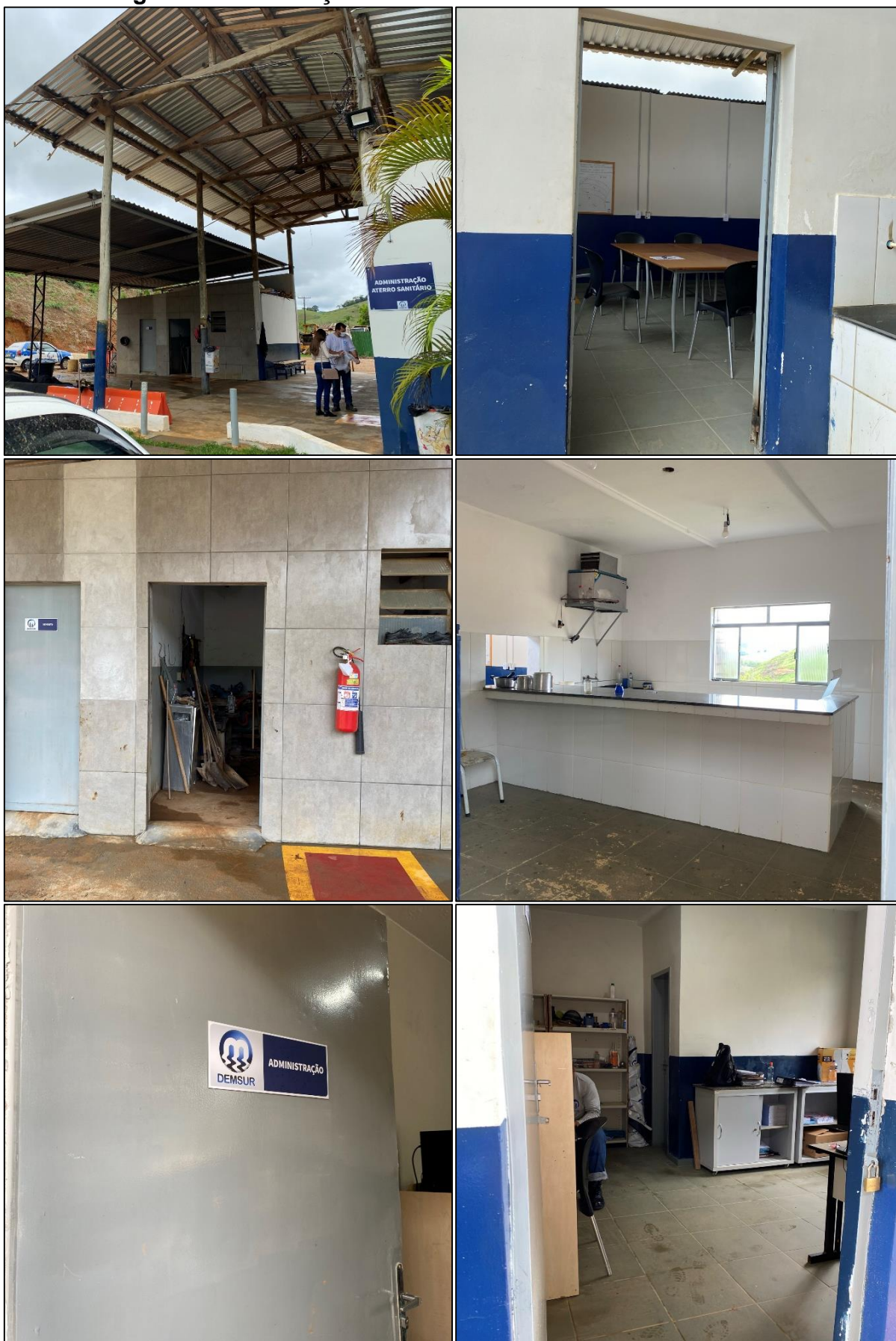
Figura 19 – Instalações físicas do aterro sanitário de Muriaé.
