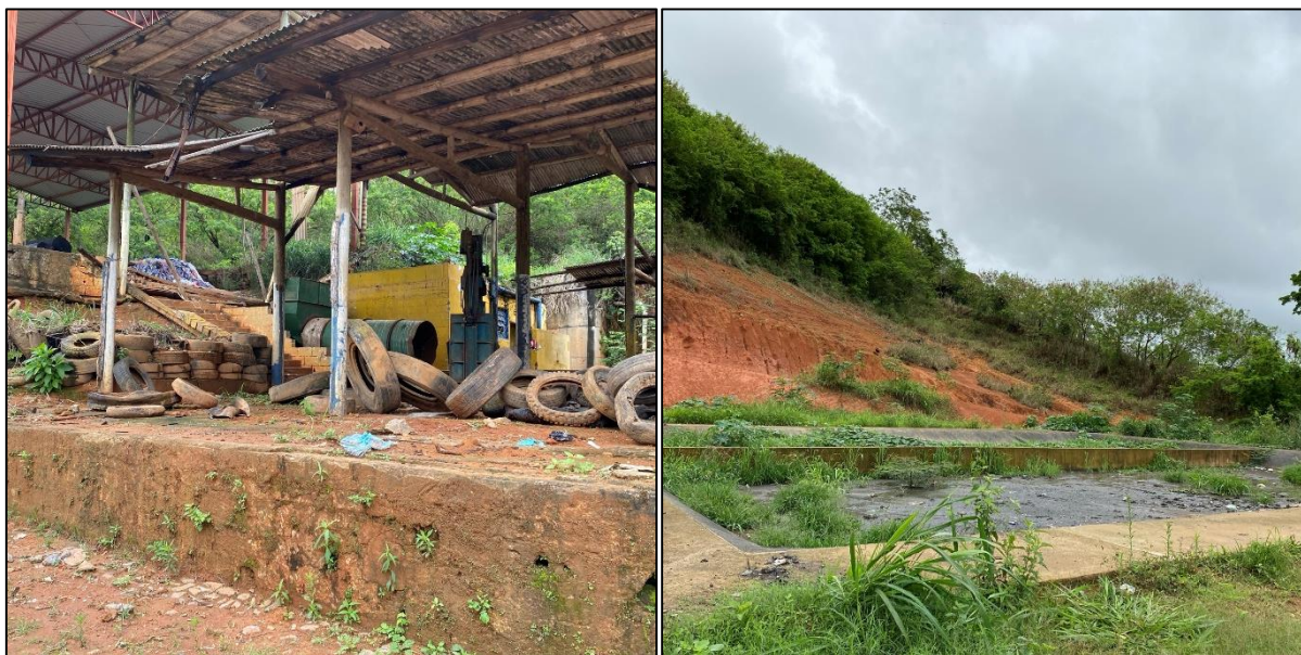
Figura 22 – Local para disposição de pneus e leito de secagem de lodo no aterro sanitário de Muriaé.
