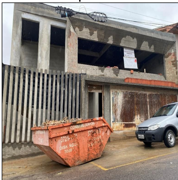
Figura 70 – Acondicionamento temporário de RCC em caçambas metálicas.
