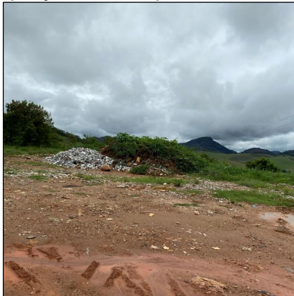
Figura 75 – Disposição final inadequada de RCC no aterro sanitário.
