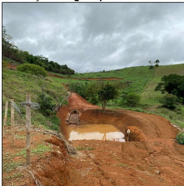
Figura 25 – Bacia de retenção de águas pluviais do aterro sanitário de Muriaé.
