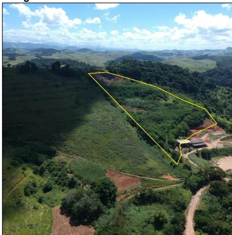
Figura 17 – Vista aérea do aterro controlado.
