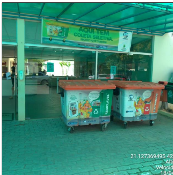
Figura 82 – Contêineres para coleta de resíduos recicláveis e eletrônicos localizados no Instituto Federal do Sudeste de MG.
