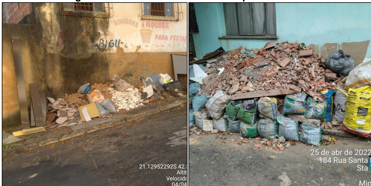
Figura 71 – Acondicionamento inadequado de RCC.
