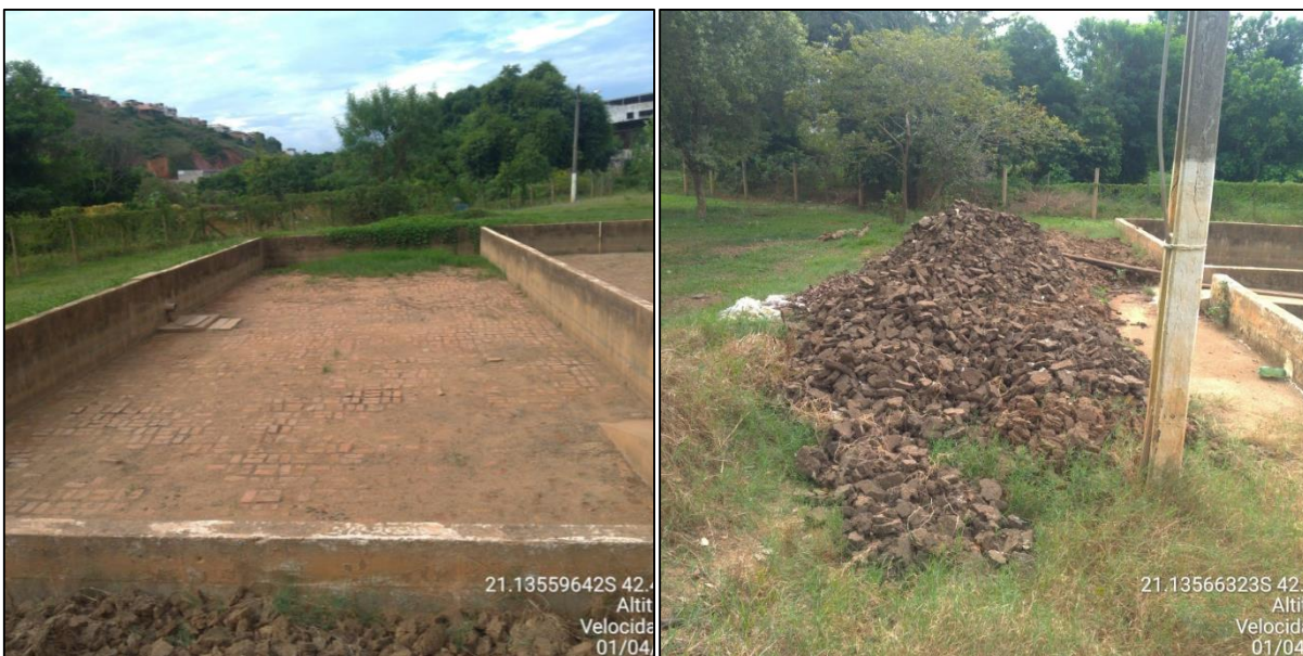
Figura 55 – Leito de secagem e acondicionamento do lodo seco na ETE José Cirilo.
