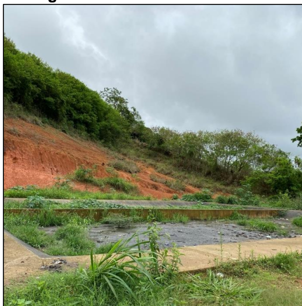
Figura 56 – Leito de secagem do lodo localizado no aterro sanitário de Muriaé.
