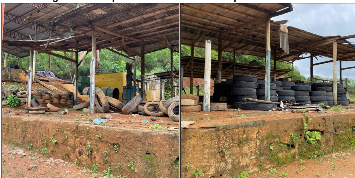
Figura 80 – Galpão de armazenamento de pneus inservíveis.
