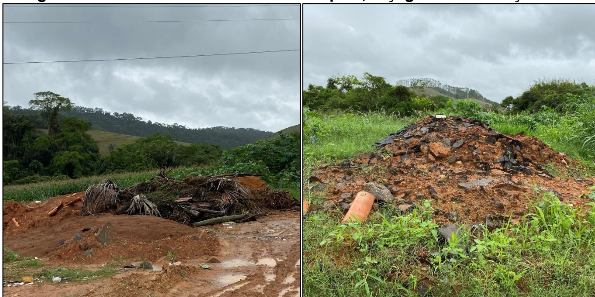
Figura 50 – Bota fora dos resíduos de capina, roçagem e construção civil.
