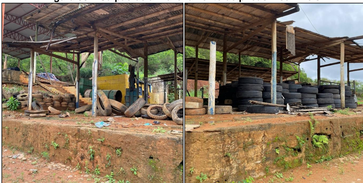
Figura 80 – Galpão de armazenamento de pneus inservíveis.
