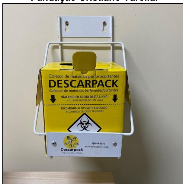
Figura 68 – Recipiente de acondicionamento dos resíduos perfurocortantes: Fundação Cristiano Varela.
