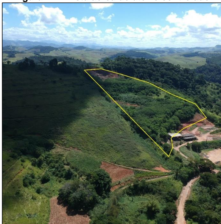
Figura 17 – Vista aérea do aterro controlado.
