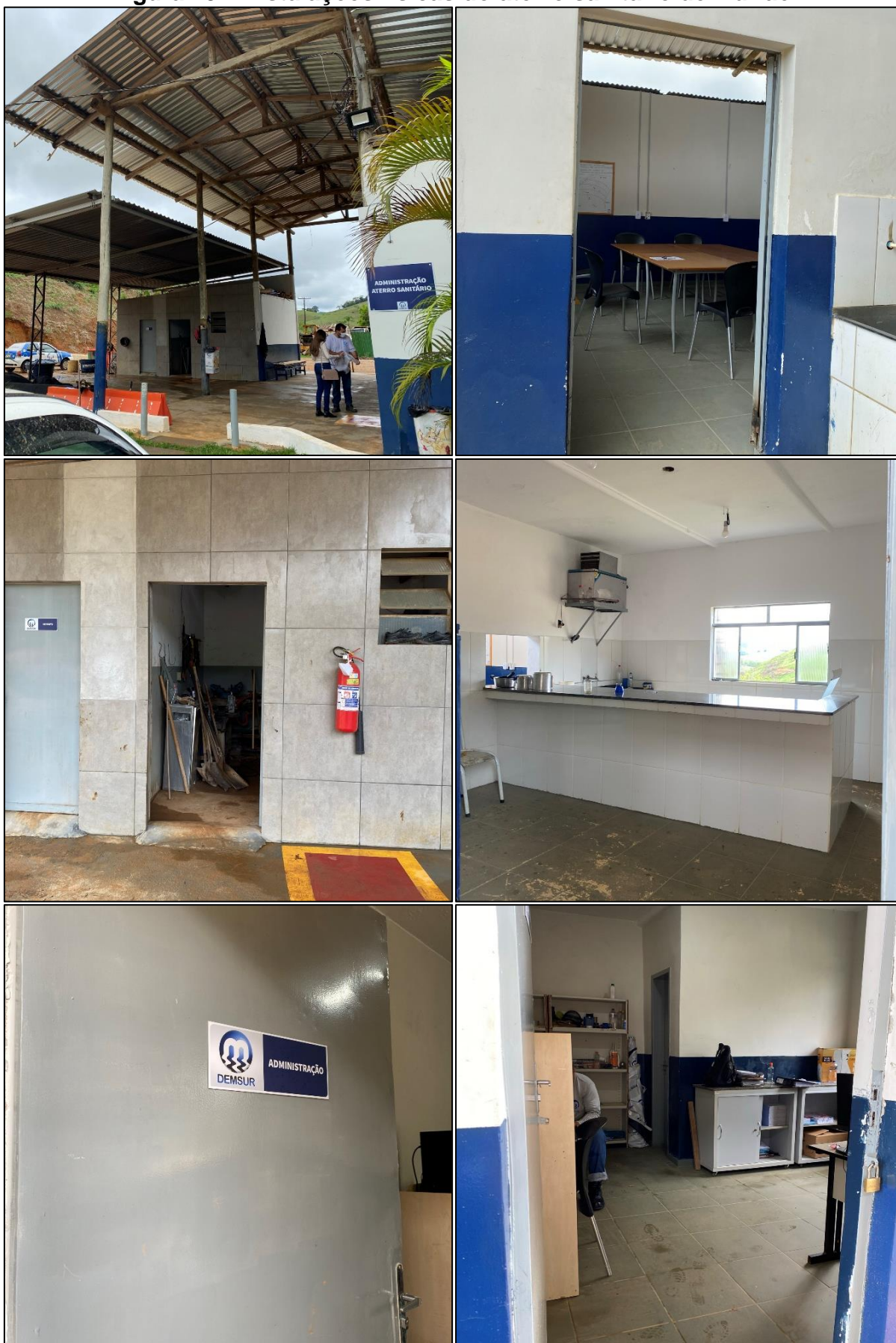
Figura 19 – Instalações físicas do aterro sanitário de Muriaé.
