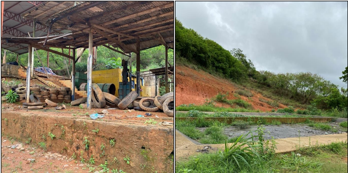
Figura 22 – Local para disposição de pneus e leito de secagem de lodo no aterro sanitário de Muriaé.
