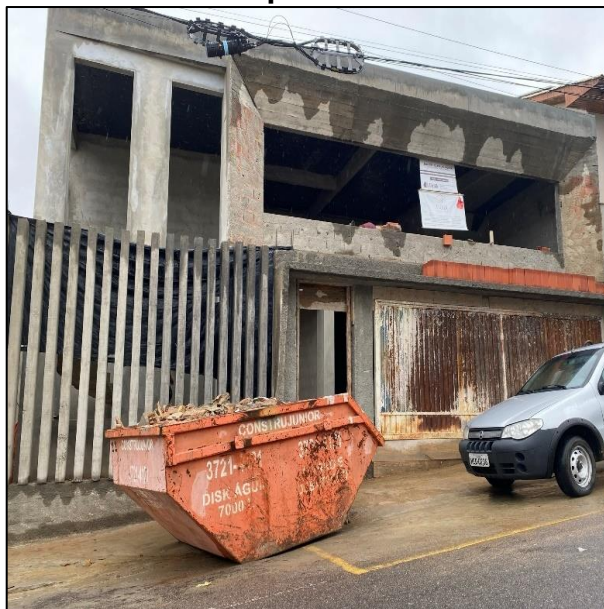
Figura 70 – Acondicionamento temporário de RCC em caçambas metálicas.
