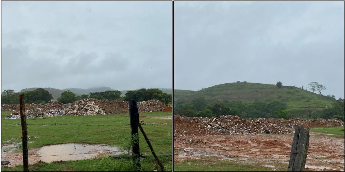
Figura 116 – Área irregular de disposição final de RCC e entulhos.
