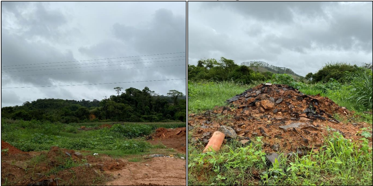
Figura 115 – Área licenciada para disposição final de resíduos da construção civil e de resíduos não perigosos.
