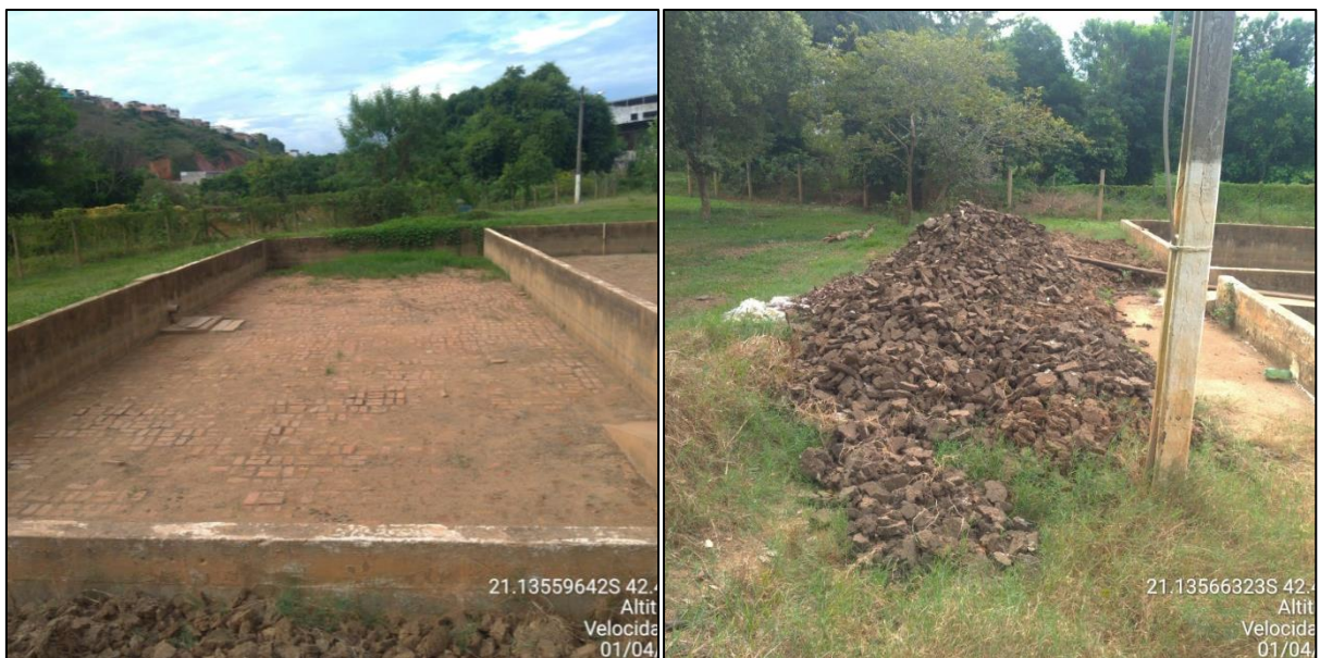
Figura 55 – Leito de secagem e acondicionamento do lodo seco na ETE José Cirilo.
