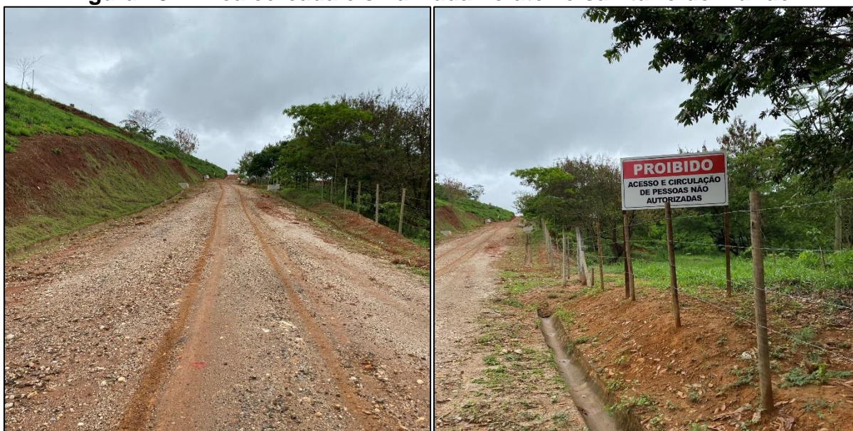
Figura 18 – Área cercada e sinalizada no aterro sanitário de Muriaé.
