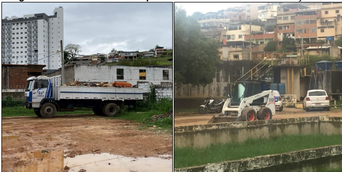
Figura 72 – Veículos utilizados para coleta de resíduos da construção civil.
