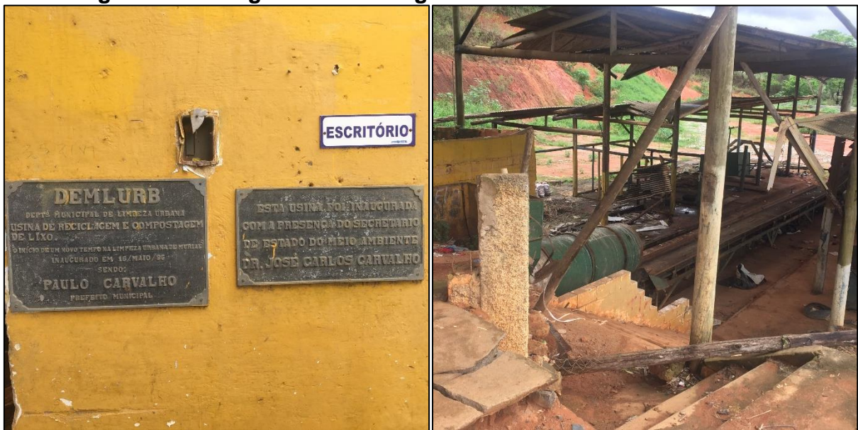
Figura 20 – Antiga usina de triagem do aterro sanitário de Muriaé.
